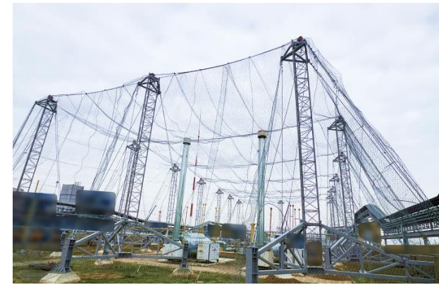
ЗОК «ЗГК-ПАНЦИРЬ» на базе опорных мачт и армированной габионной сетки «ПАНЦИРЬ»
