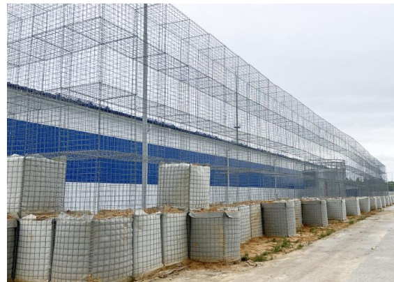
Габионно-сетчатые конструкции ЗГК-ФОРТ-М высотой на базе ГНТ
