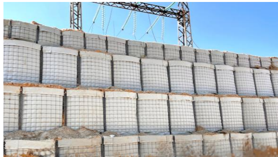
Габионы насыпного типа (ГНТ) для противоосколочных стен высотой до 6 м.
