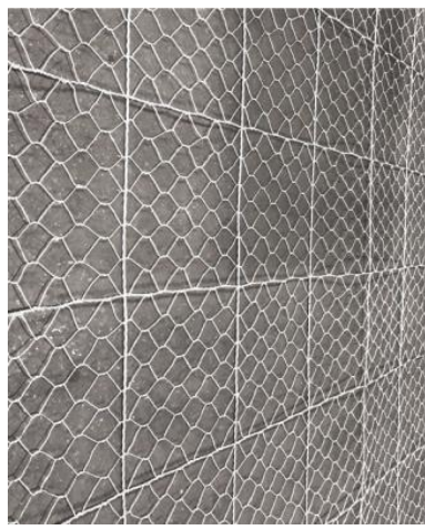
Сетка «ЗГК-ПАНЦИРЬ-ХАРДКОР» с армированием
